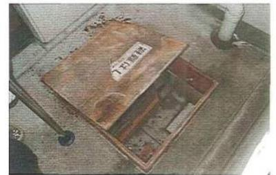
上蓋が開いたら、梯子がネジ止めで外せるかを確認し、外せれば適した工具を使用して取り外します。ネジ止めで外せなければタガネ、ガスなどを用いて外します。
