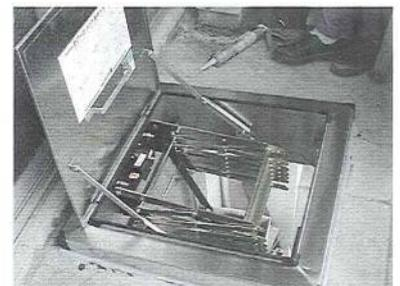
(1) 梯子を吊元ボルトで取り付け、仮締めします。締め付けはスプリングワッシャがつぶれきらない程度で行ってください。
